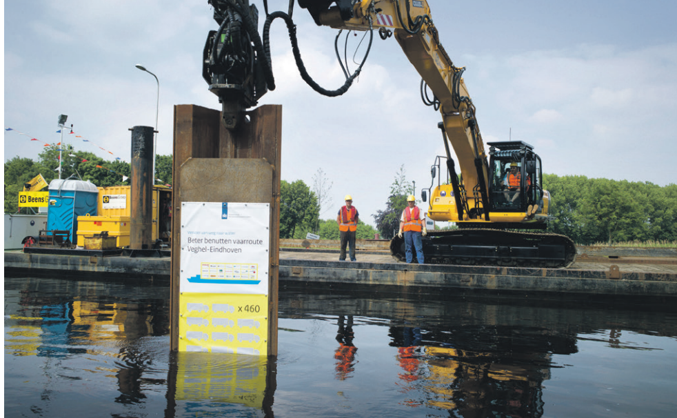
De eerste damwand wordt geplaatst in de Zuid-Willemsvaart bij Beek en Donk.
